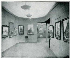
Fig. 2. — GALERIE D'ART « LE PORTIQUE ». Eclairage indirect par coupes Mazda munies de lampes de 300 watts. Ce dispositif présente l'inconvénient de ne pas éclairer suffisamment les tableaux.
