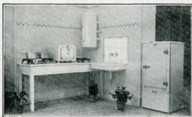
La cuisine électrique
