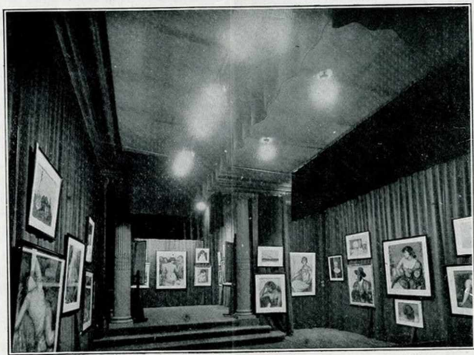
Fig. 1. — GALERIE JAVAL ET BOURDEAUX Eclairage direct au moyen de rampes Rox disposées obliquement et que l'on distingue très bien sur cette photographie.
